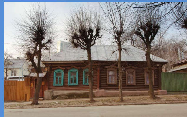
г.Рязань, цокольная часть домов
