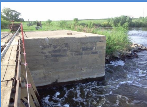
Кузьминский шлюз, устой плотины, 1912г.
